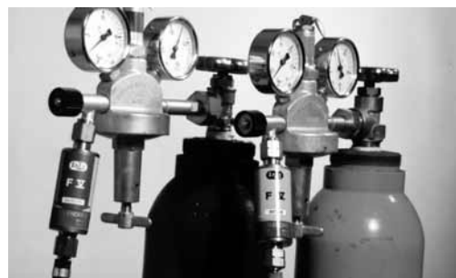
Figura 6: posto di saldatura a gas con riduttori di pressione, valvole antiriflusso del gas e dispositivo di arresto della fiamma.
