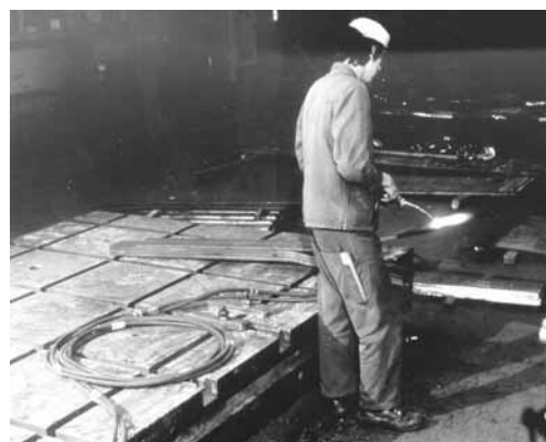
Figura 2: arrotolamento corretto di tubi a fianco del posto di lavoro per evitare il rischio di inciampare.
