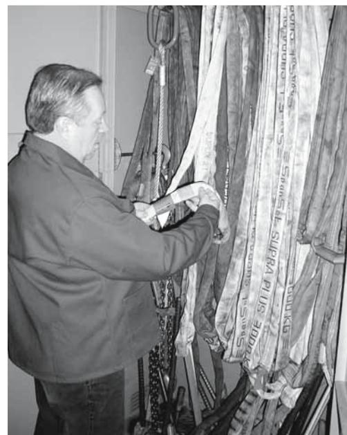
Fig. 5: controllo degli accessori di imbracatura da parte di una persona qualificata.
