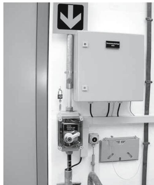
Fig. 4: interruttore generale della gru disinserito e bloccato con un lucchetto per evitare che possa essere azionato accidentalmente.
