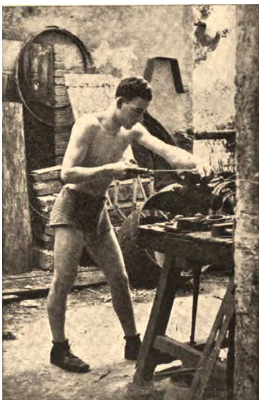
Limatore che fa un lavoro di grossatura
