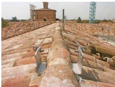
Conforme alle norme UNI EN 795 tipo C e UNI CEN/TS 16415 e UNI 11578, la **linea vita LVB** è caratterizzata da una deformabilità che le permette, in caso di caduta dell'operatore, di assorbire la maggior parte dell'energia di caduta. Il risultato è che da un lato si salvaguarda la salute dell'operatore che subisce lo strappo di arresto, dall'altro lato si evitano danneggiamenti alla struttura stessa.
