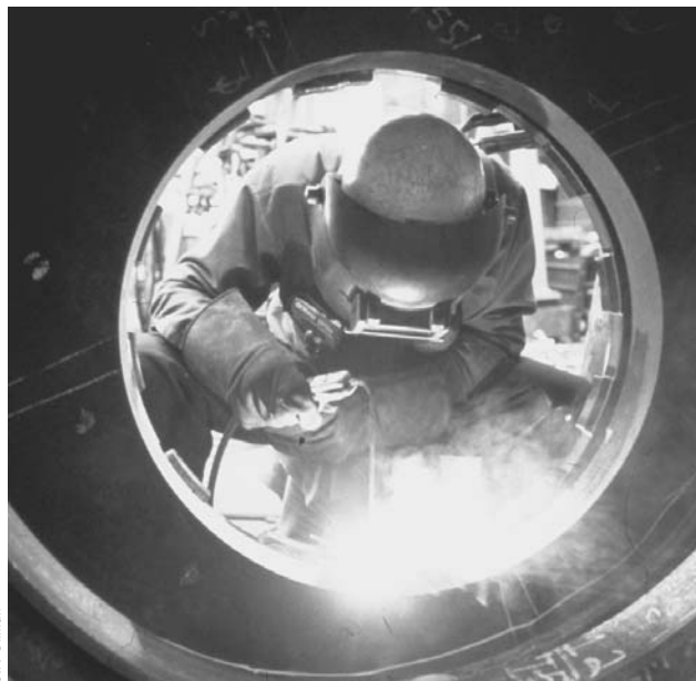
Figure 82.3 • Soudage dans un espace confiné
