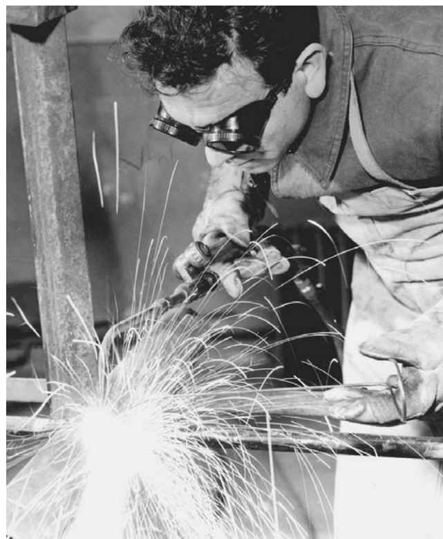
Figure 82.2 • Soudage au gaz au chalumeau, avec baguette de métal d'apport
