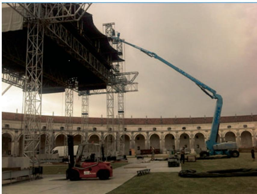
Figura 3 - 4 Scaffolder. Montaggio opere temporanee con l'ausilio di autogrù e P.L.E.
