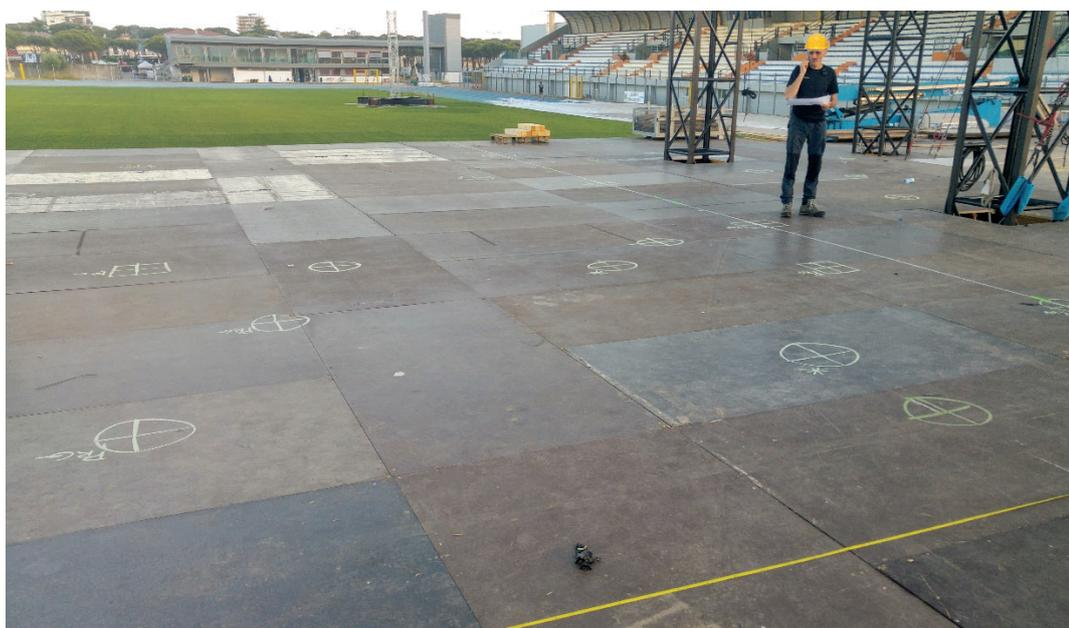
**Figura 21** Head Rigger. Verifica dei punti del mark floor
