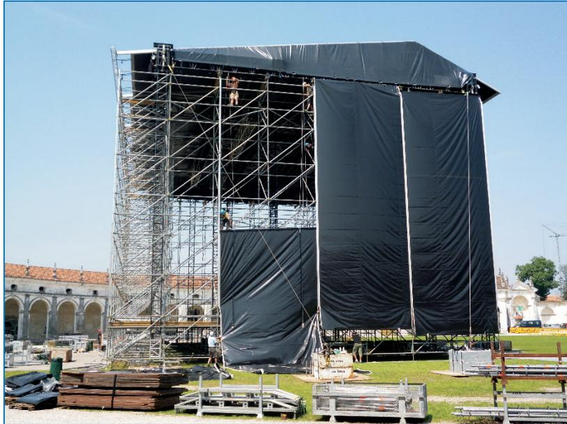
Figure 7 - 8 Scaffolder. Montaggio teli di copertura
