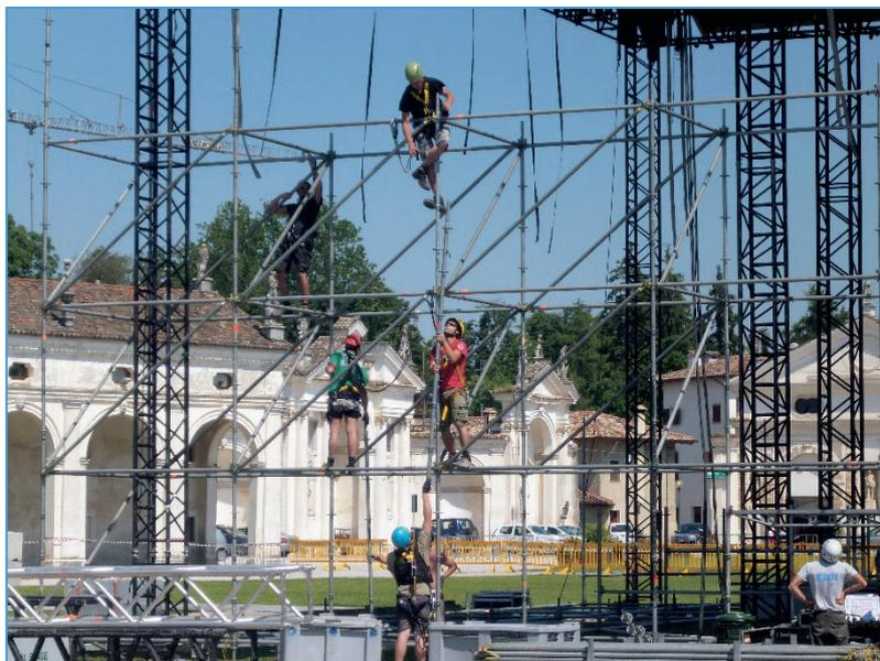
**Figura 6** Basic Scaffolder. Montaggio con l'ausilio dei climber
