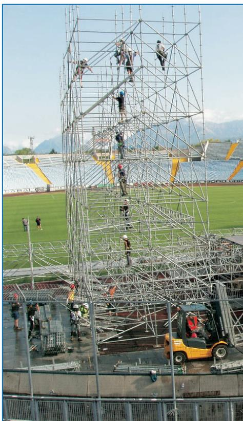
**Figure 2** Climber e Scaffolder. Montaggio opere temporanee
