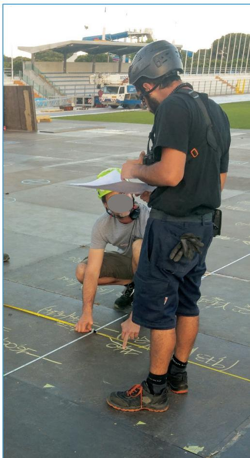
**Figura 20** Rigger impegnati nella realizzazione del mark floor
