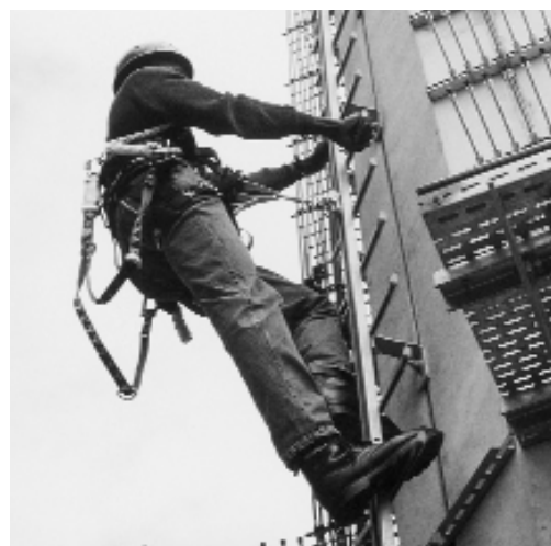
Il montatore è assicurato con cintura e dispositivo anticaduta.
