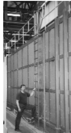
Scala fissa a pioli che deve essere usata solo raramente, per eseguire lavori di manutenzione.
