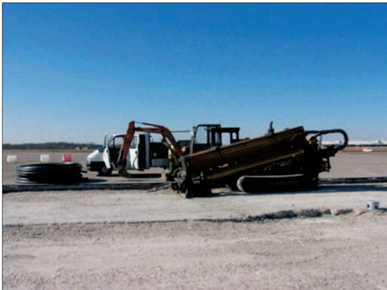
Fig. 5: Perforatrice montata su carro cingolato (Fonte 1)
