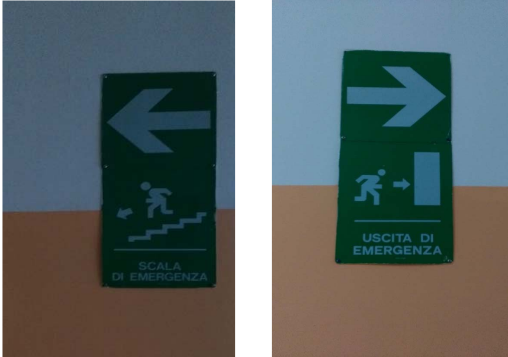
Foto 4, 5 – Segnaletica via di esodo
