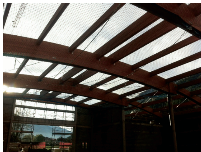
Figura 5.3.2-1 - Esempio di sistema S: copertura in legno
