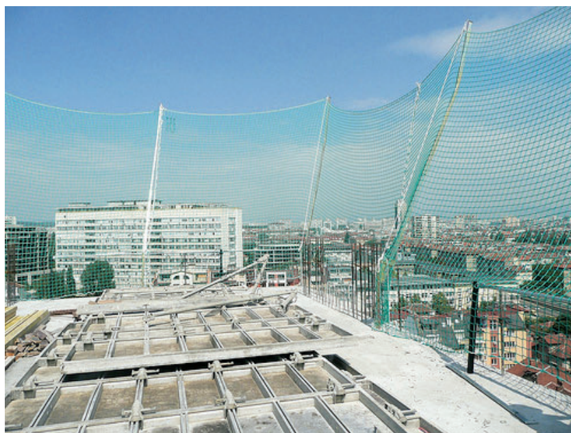
Figura 5.3.2-9 - Esempio di sistema V: rete di sicurezza fissata ad un sostegno a forza - Particolari
