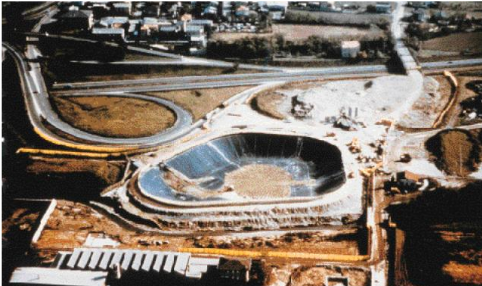
Veduta aerea della vasca di Meda durante la fase di riempimento
