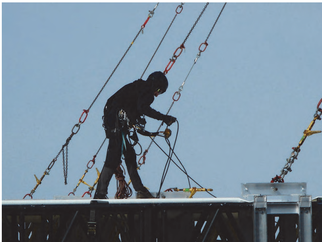
Figura 2.A1 –1 Rigger sulla copertura di un palco – Progressione su fune (Gentile concessione Luca Guidolin)
