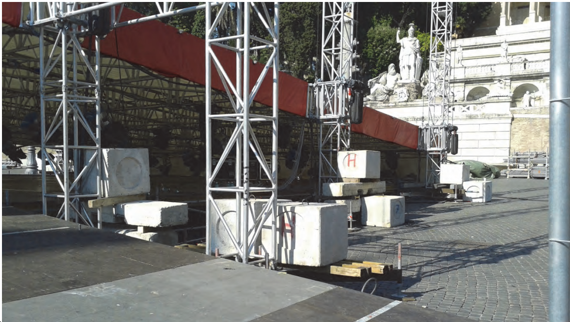
Figura 1.3 – 4 Esempio di posizionamento della zavorra
