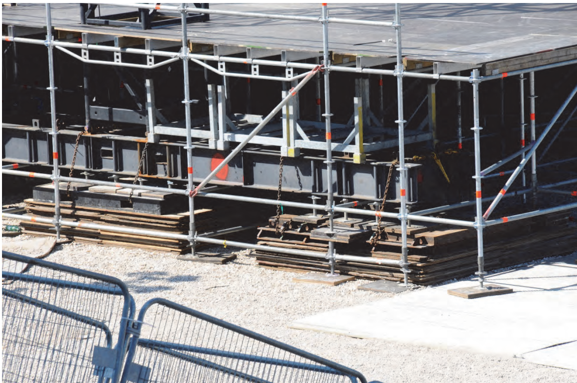
Figura 1.3 – 5 Esempio di livellamento
