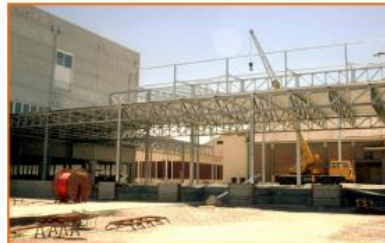
Costruzione cella di deposito prodotti lattiero caseari. Reggio Emilia - 1990
