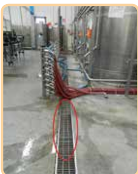
Canaline deflusso dei liquidi in cantina
