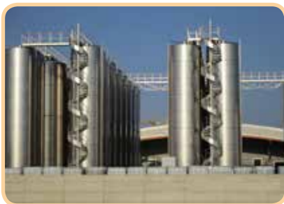
Cisterne nelle aree esterne: sistemi di accesso in quota protetti contro le cadute dall'alto
