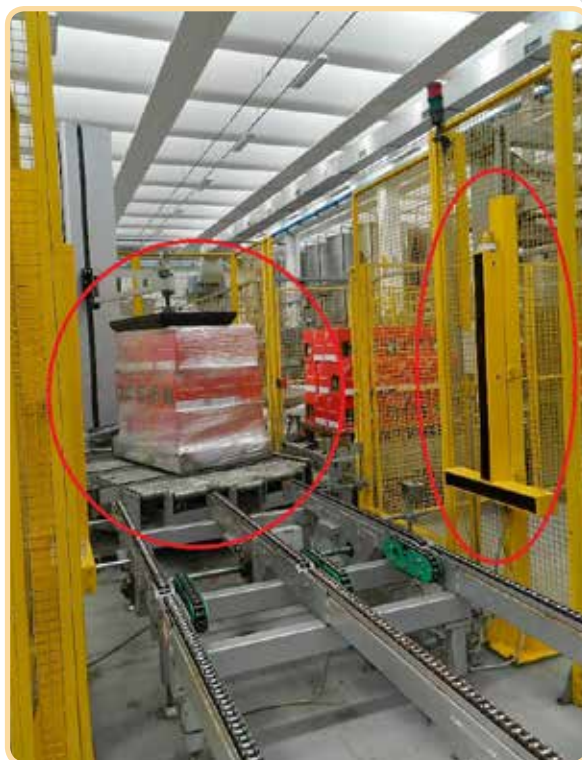
Pallettizzatore con fasciatrice e barriere immateriali
