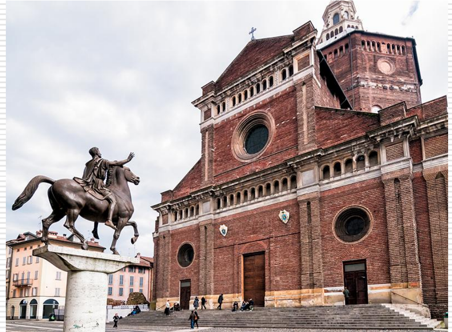
Dopo il crollo
