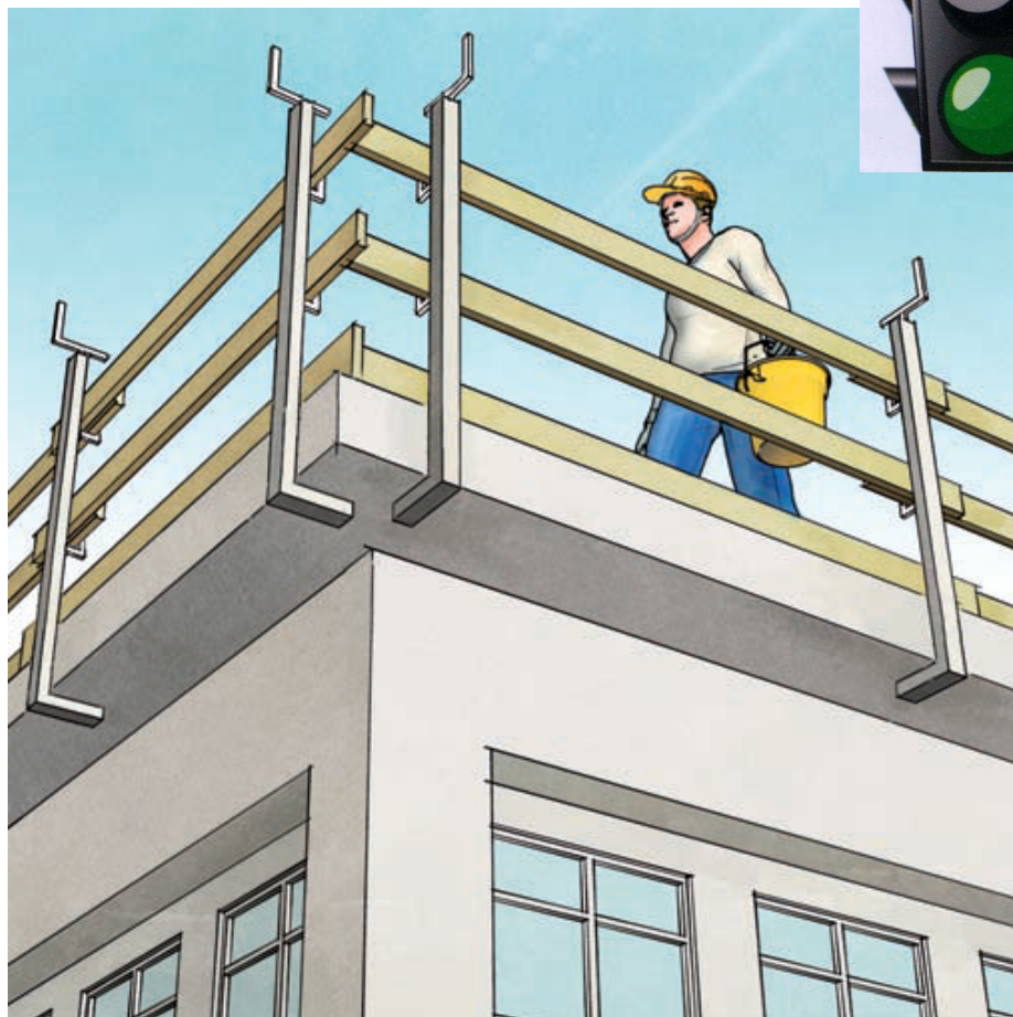
Parapetto provvisorio del tipo a morsa.
