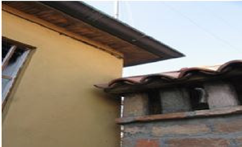
Fig. 3 - Caso di intossicazione da monossido di carbonio – comignolo di una caldaia di tipo B
