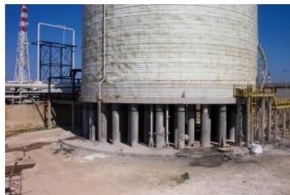
Ripresa fotografica nel corso dei lavori
