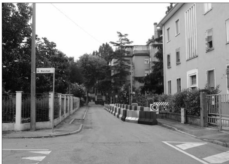
Figura 4 - Manutenzione rete fognaria, vista "a valle" delle aree oggetto dell'intervento.
