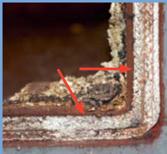
Nastro isolante per caldaia
