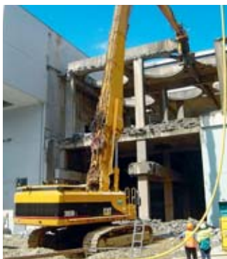
Smantellamento di un edificio
