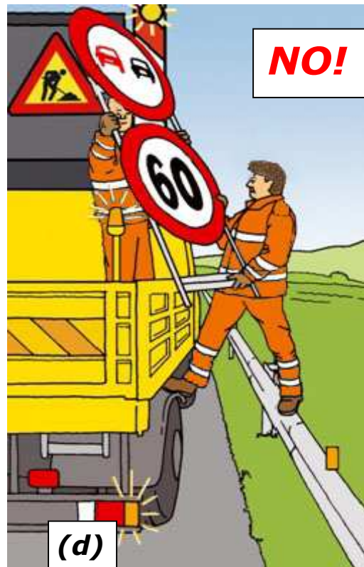
Figura 15 – Prelevamento della segnaletica da automezzo: comportamenti corretti (a), (c) e scorretti (b), (d)
