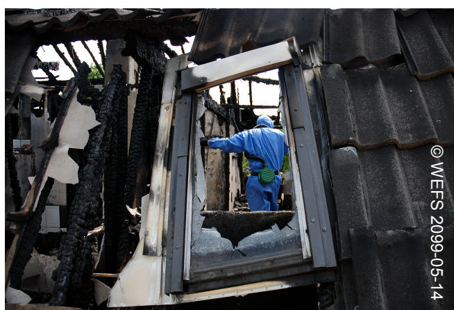
Travaux d'enlèvement de l'amiante après un incendie
