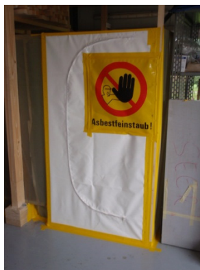
4 Area da bonificare confinata e segnalata
