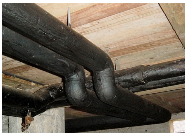
1 Per intagliare e rimuovere la guaina bituminosa è sufficiente un taglierino.
