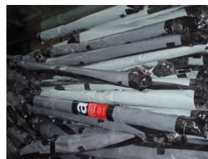
5 Tubi avvolti nella plastica pronti per l'invio alla ditta di bonifica
