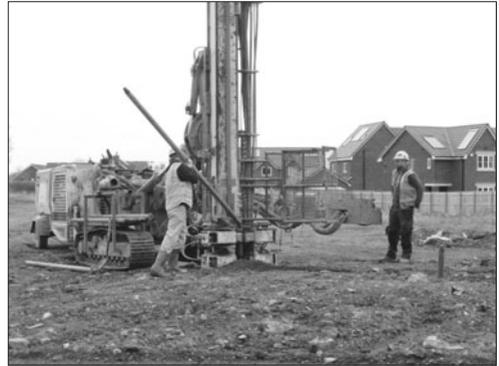
Inserimento e montaggio asta di perforazione
