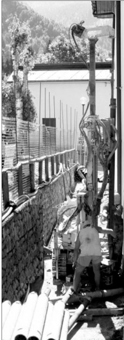
**Lavori in zone con vie di accesso limitate:** la geometria e le dimensioni della zona di lavoro non consentono l'accesso ed il posizionamento della macchina con la gabbia montata. Non risulta inoltre possibile la realizzazione dei fori alla distanza richiesta dal progetto, laddove non risulti possibile l'adozione di altra soluzione progettuale.
