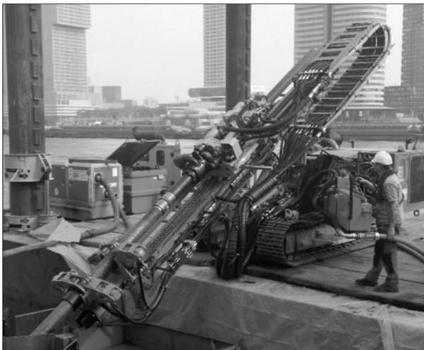
**Lavori in prossimità di banchine, su pontoni o piattaforme galleggianti:** il posizionamento dell'organo perforatore comporta il ricorso a gru o manipolatori per la sostituzione delle aste, per cui è necessario operare senza gabbia onde evitare interferenze.
