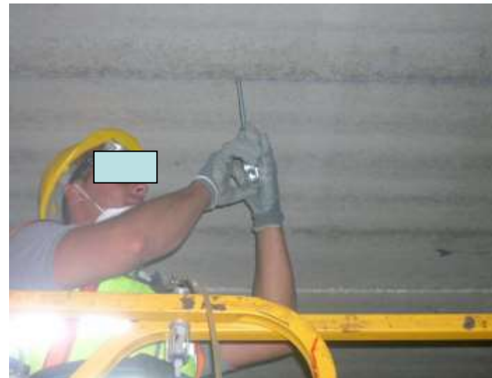
Lavori edilizia all'interno
