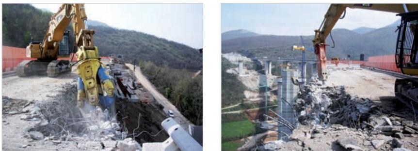
Demolizione mediante cesoie e martellone
