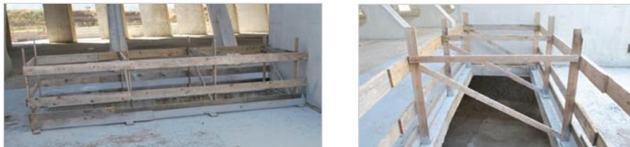
Parapetti provvisori a protezione di fori nei solai
