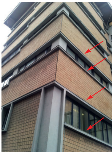
Visione di insieme dell'edificio con indicazione della posizione delle soglie in cemento amianto
