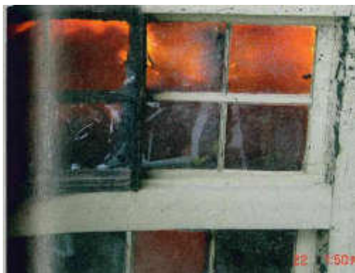
Una finestra di vetro fratturato dall'esposizione al calore durante un normale incendio (post-flashover).
