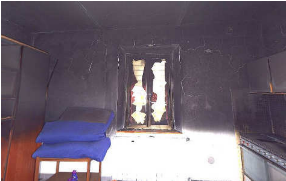
Foto NIA – Finestra con segni del deposito di fuliggine su tutta la superficie
