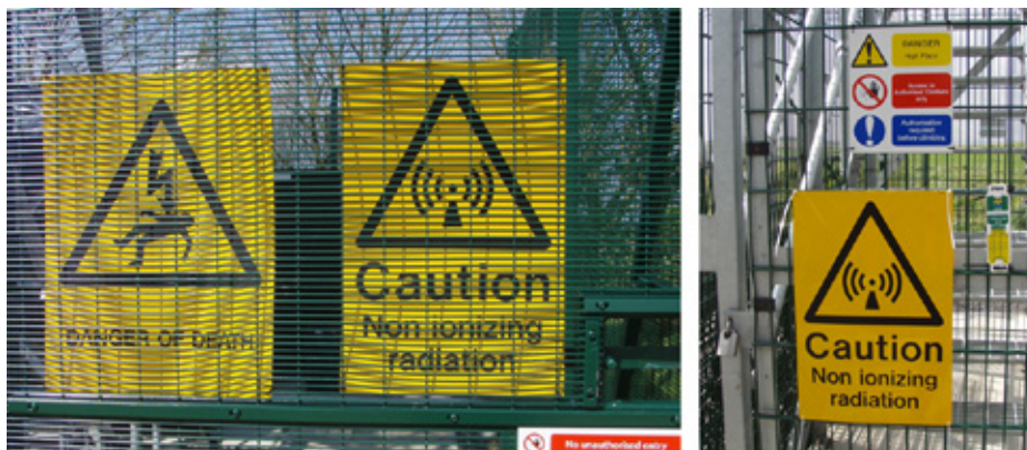
Figura 12.4 — Segnali di avvertimento sul cancello dell'area recintata del radar (a sinistra) e sul cancello della torre dell'antenna (a destra)
