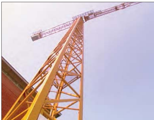
Figura 2 - Gru a torre
