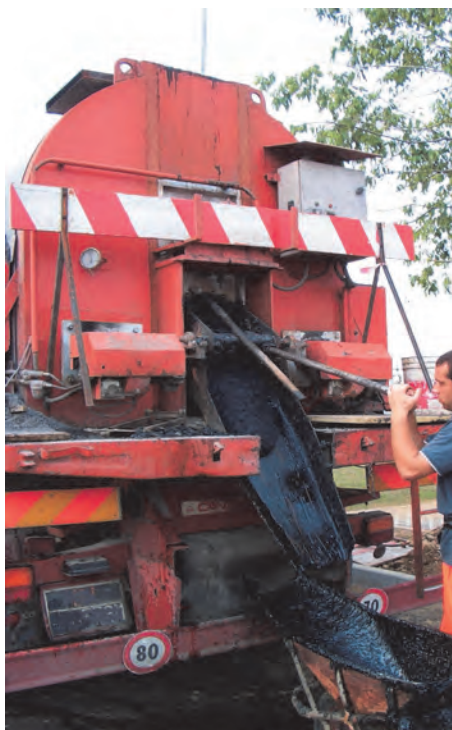
Figura 31 - Prelevamento di asfalto colato da "bonza"
