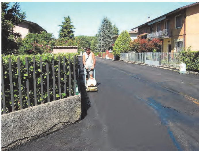
Figura 28 - Compattazione asfalto con piastra vibrante
