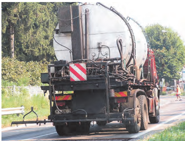
Figura 23 - Applicazione emulsione bituminosa automatica
