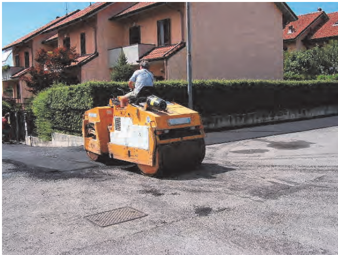
Figura 27 - Compattazione asfalto con rullo
