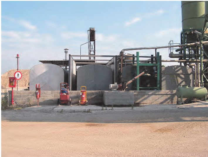
Figura 16 - Stoccaggio bitume nello stabilimento di produzione
