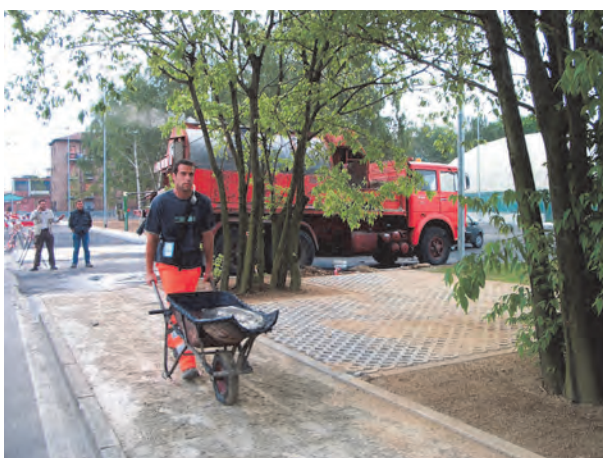
Figura 32 - Trasporto di asfalto colato con carriola
