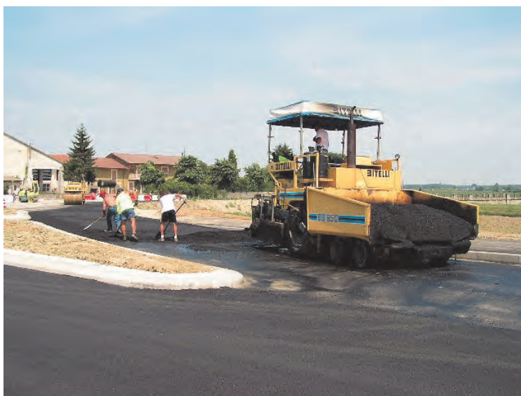
Figura 25 - Stesa asfalto con vibrofinitrice
