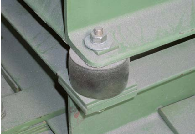
68 Elemento in gomma per il basamento di un ventilatore.
