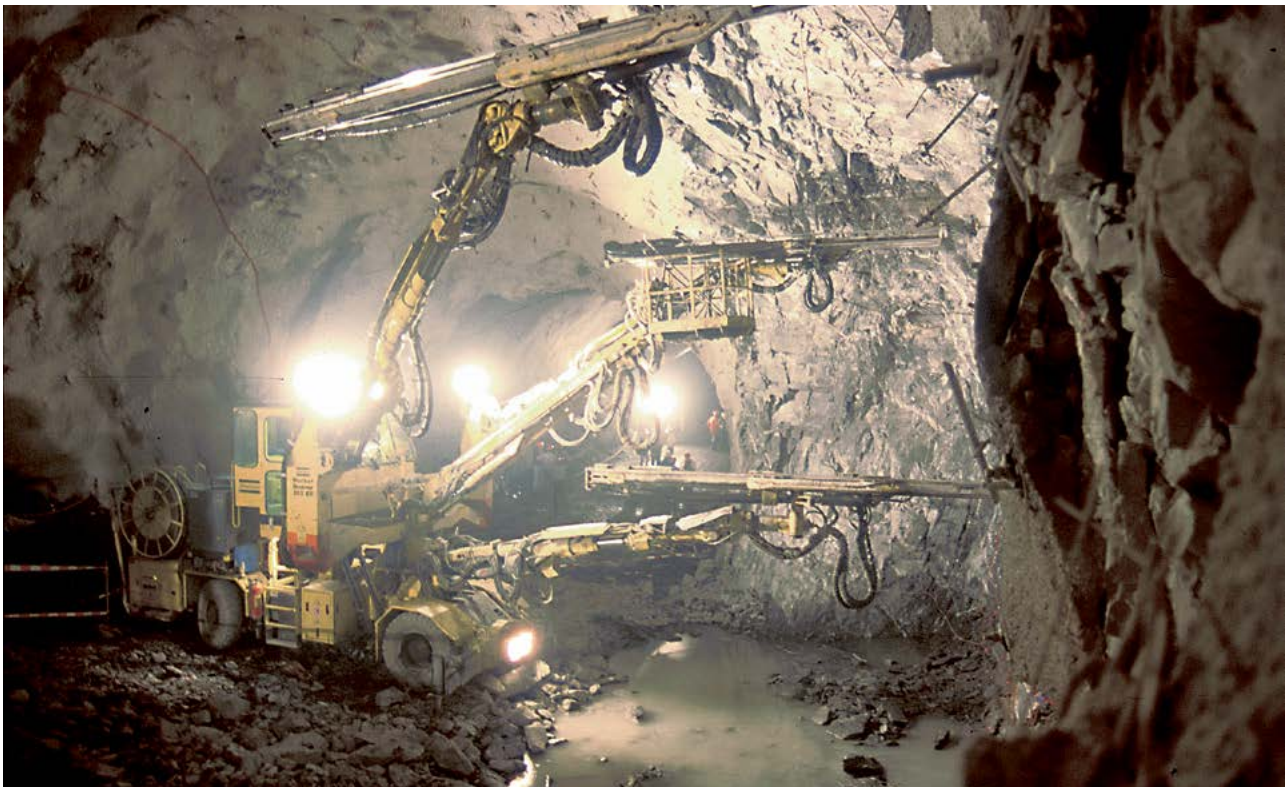
1 Elevata esposizione al rumore durante i lavori all'interno di un tunnel.
