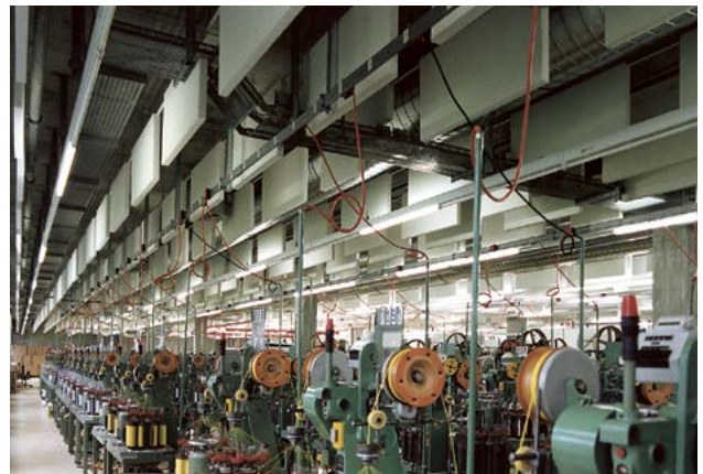
82 Soffitto fonoassorbente in un'industria tessile.
