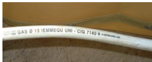
8.20 - Tubo UNI 7140 con data di sostituzione
