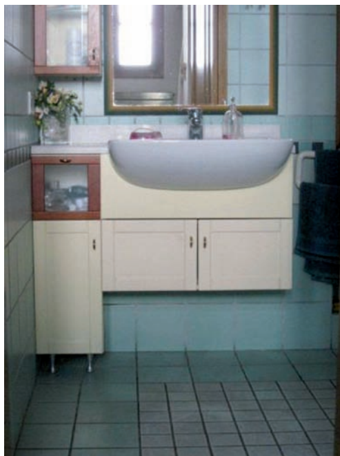
19.8 - Lavandino con ripiano orizzontale che consente l'appoggio di oggetti, inserito in un mobile sospeso, che consente l'avvicinamento anche a soggetti che utilizzano ausili
