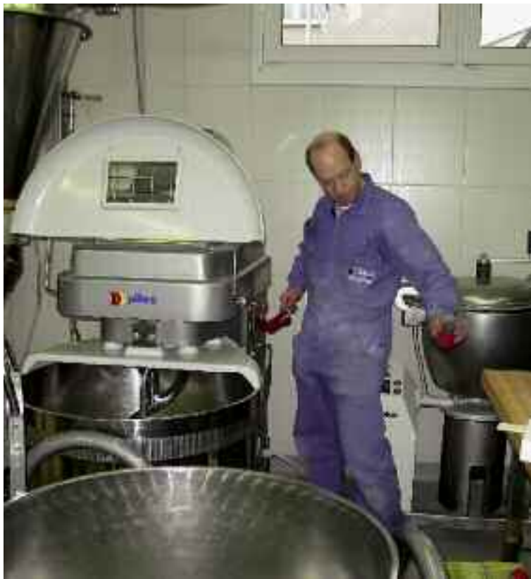
Installatore durante un intervento di manutenzione.
