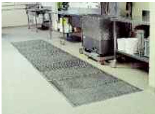
Griglie posate a filo del pavimento negli ambienti umidi.
