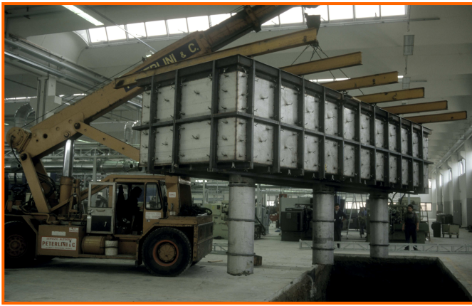
Costruzione e posa in opera di vasca in acciaio inox di base per macchina utensile a controllo numerico. Reggio Emilia 1996.
