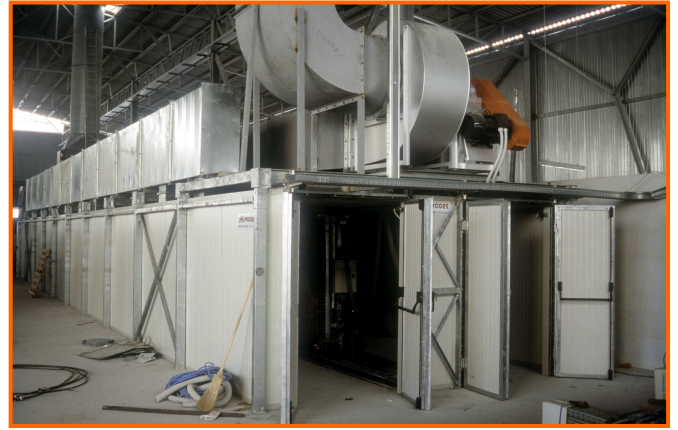
Costruzione e montaggio di tunnel di essiccazione di tegole in laterizio. Grosseto - 1996
