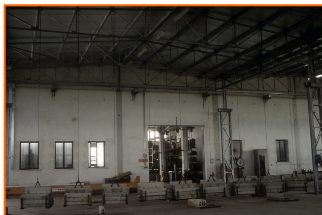
Prova di deformazione statica del tetto in acciaio di un capannone industriale. Pegognaga 1994
