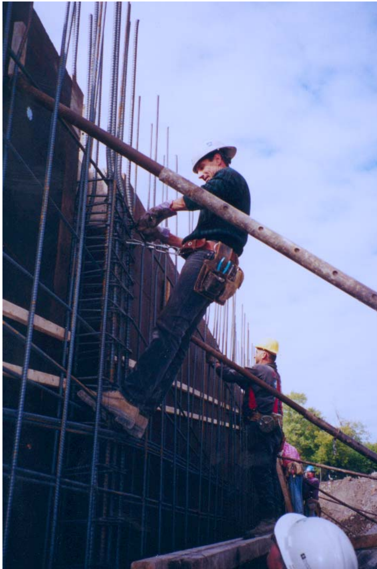
Figure 1 : Ferrailage de mur
