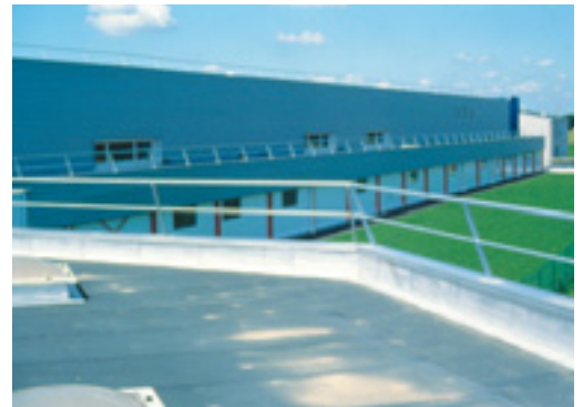
Photo 7.4. Dispositif de garde-corps évitant les chutes en périphérie de toiture.
