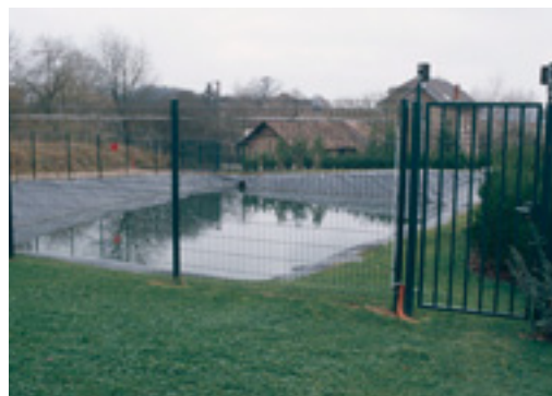
Photo 6.1.a. Réserve d'eau incendie protégée par un grillage pour prévenir le risque de noyade.
