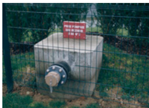
Photo 6.1.b. Prise d'eau à l'extérieur de l'enceinte grillagée.
