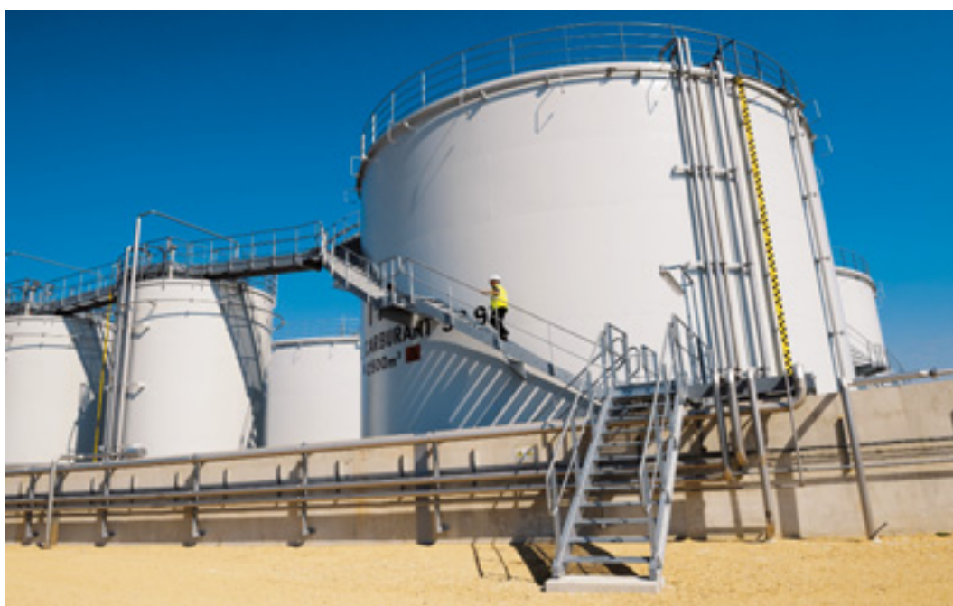
Photo 8.5. Accès et protection collective sur un silo.
