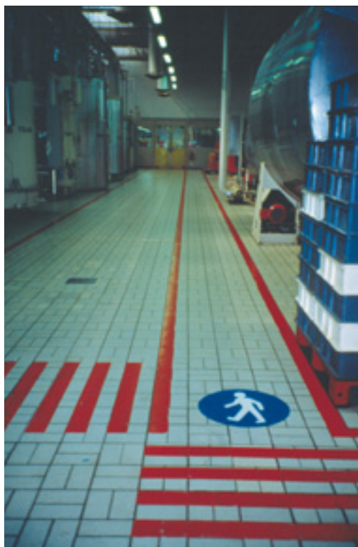
Photo 7.6. Allées de circulation intérieure, balisées et identifiées ; les sols carrelés facilitent l'entretien.
