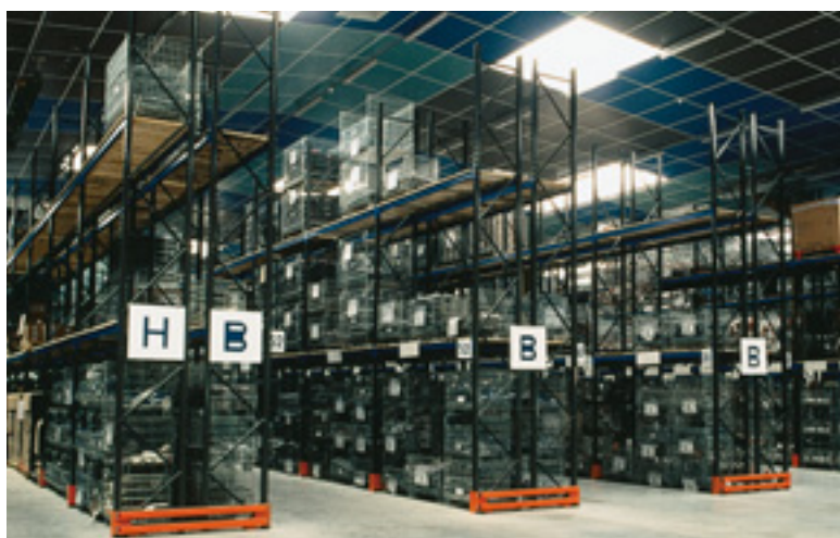
Photo 8.3. Exemple de racks aménagés sur le plan de la sécurité : plancher de positionnement et butées de pied d'échelle.
