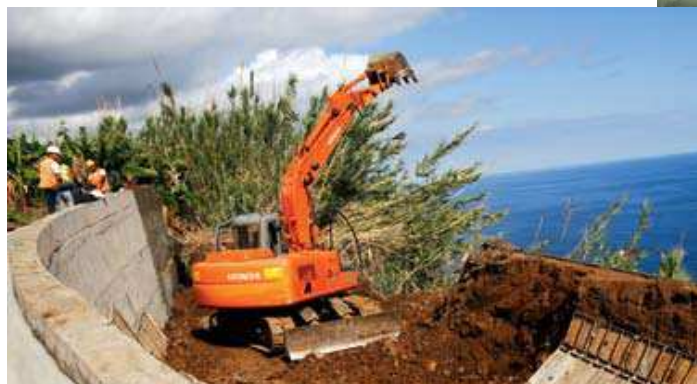
Escavatori anche come mezzo di sollevamento
