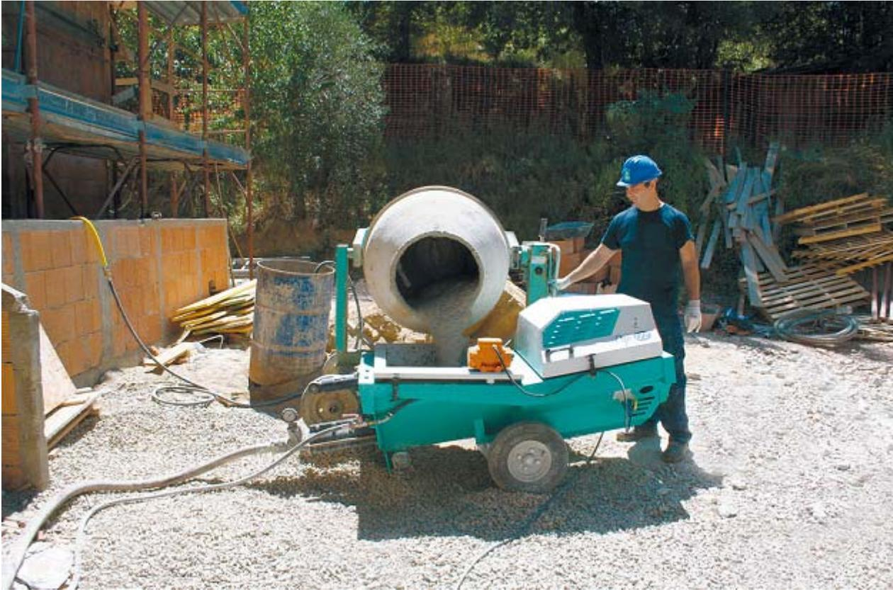
Pompa a vite alimentata da betoniera in fase di carico
