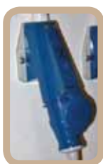
Preso IEC 309 a muro con spina inserita. Sistema monofase. (tratta dal sito Wikipedia.org)
