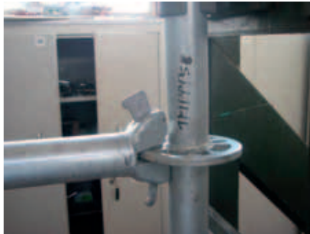
Figura 4.2.2.10-11: Fine prova dopo la rimozione dell'attrezzatura di prova
