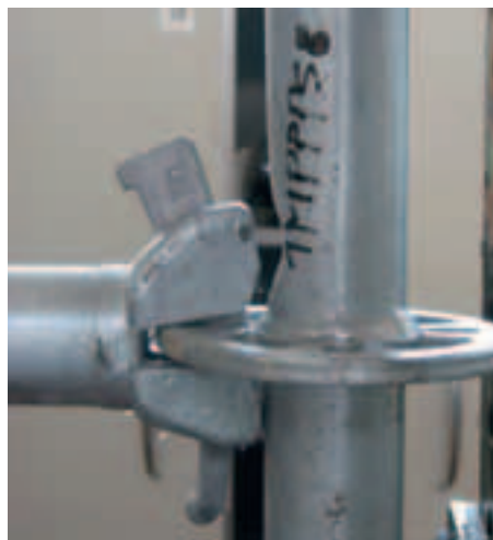
Figura 4.2.2.10-12: Fine prova dopo la rimozione dell'attrezzatura di prova - dettaglio
