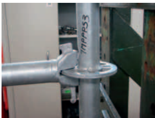
Figura 4.2.2.4-8: Fine prova dopo la rimozione dell'attrezzatura di prova
