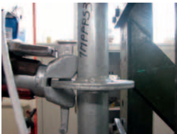
Figura 4.2.2.4-5: Evidente imbozzamento del montante
