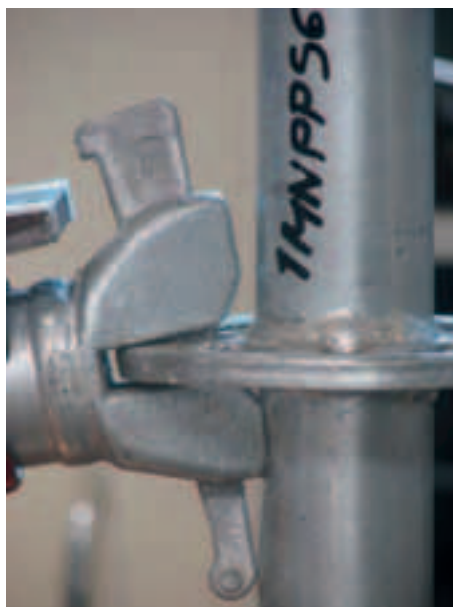
Figura 4.2.1.9-8: Contatto cuneo montante (evento c)
