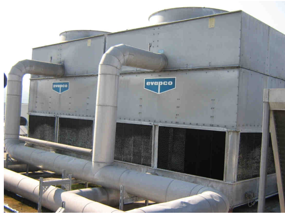
Torre Evaporativa con Ventilatori Assiali
