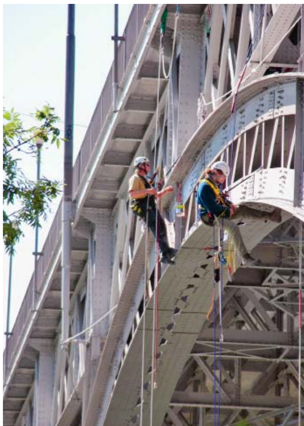
Fig. 2 Lavori in sospensione a corde portanti
