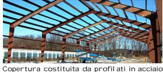
Copertura costituita da profilati in acciaio
