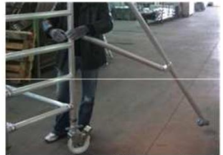
Fig.11: Montaggio dello stabilizzatore - Particolare 2
