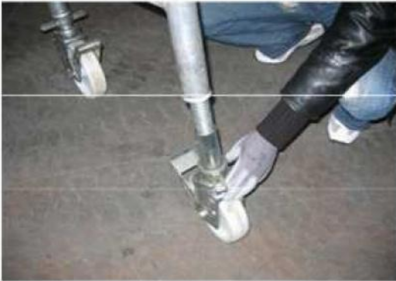
Fig.1: Inserimento delle ruote
