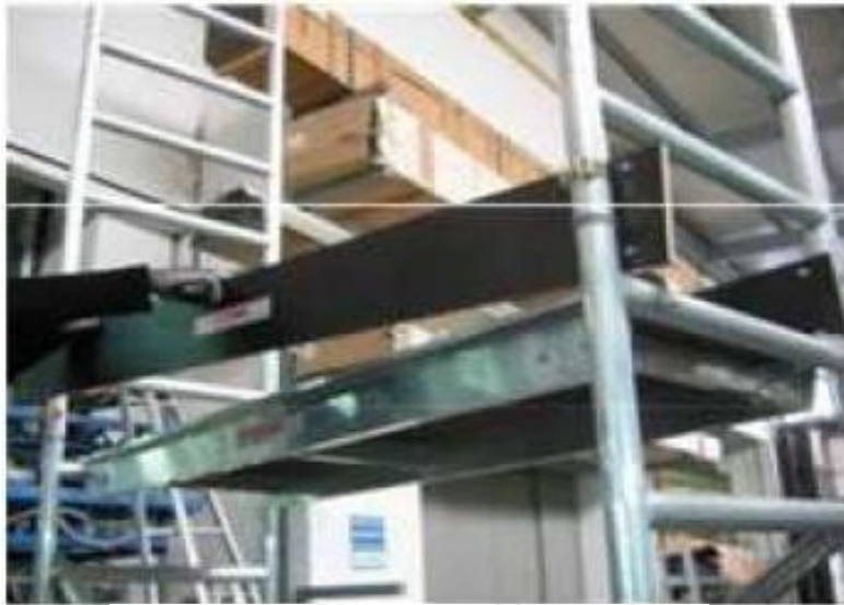
Fig.14: Montaggio tavole fermapiede
