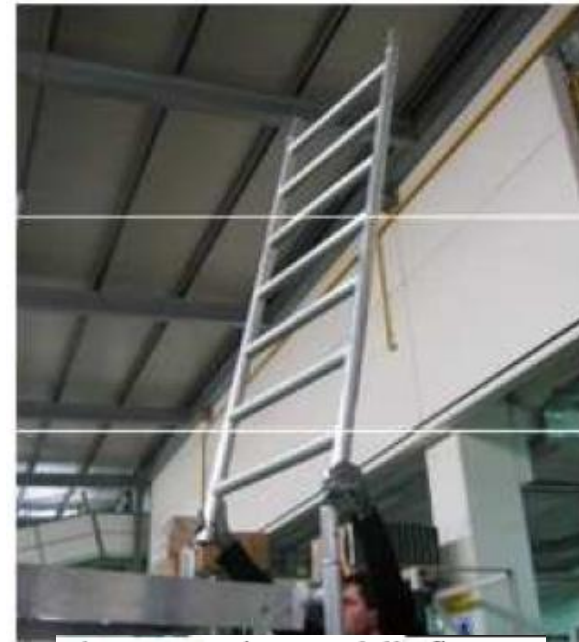
Fig.13: Inserimento delle fiancate
