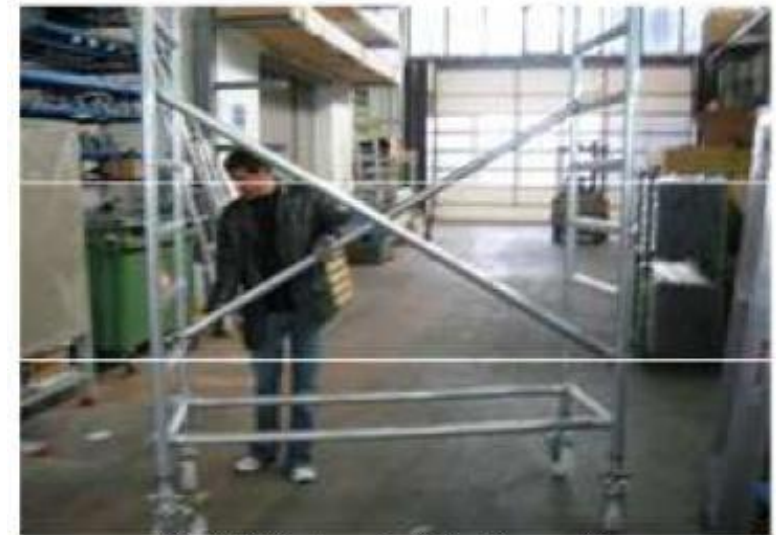
Fig.5: Montaggio delle diagonali
