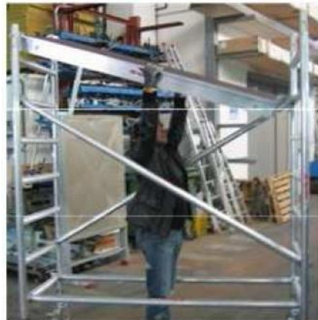
Fig.9: Montaggio del piano di lavoro
