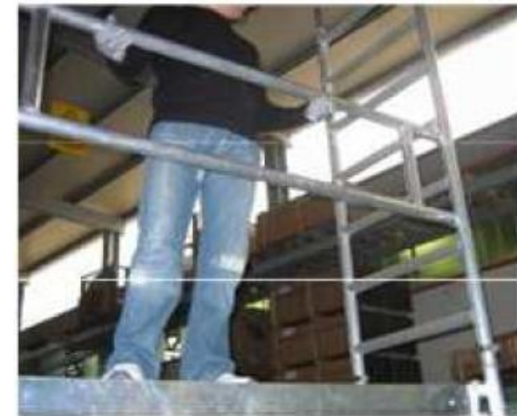
Fig.15: Inserimento dei parapetti
