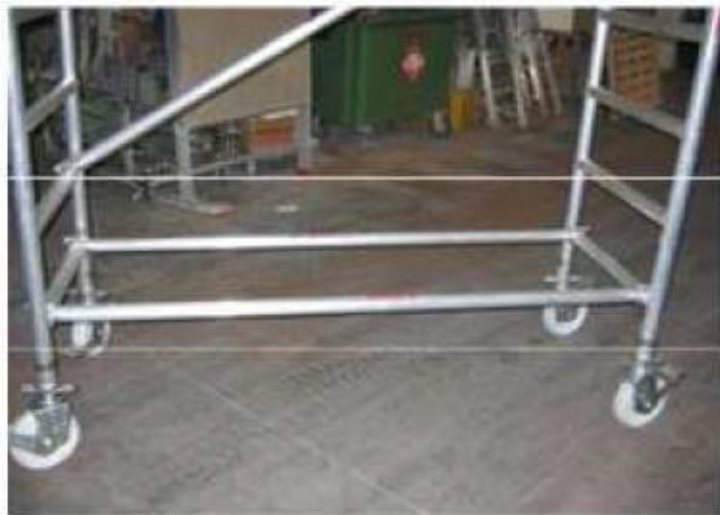
Fig.3: Montaggio delle travi orizzontali
