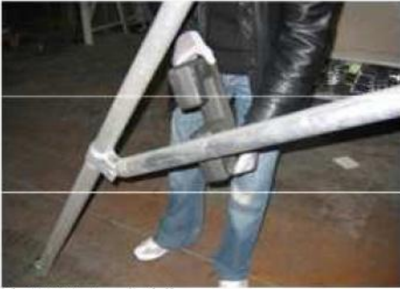
Fig.12: Montaggio delle zavorre
