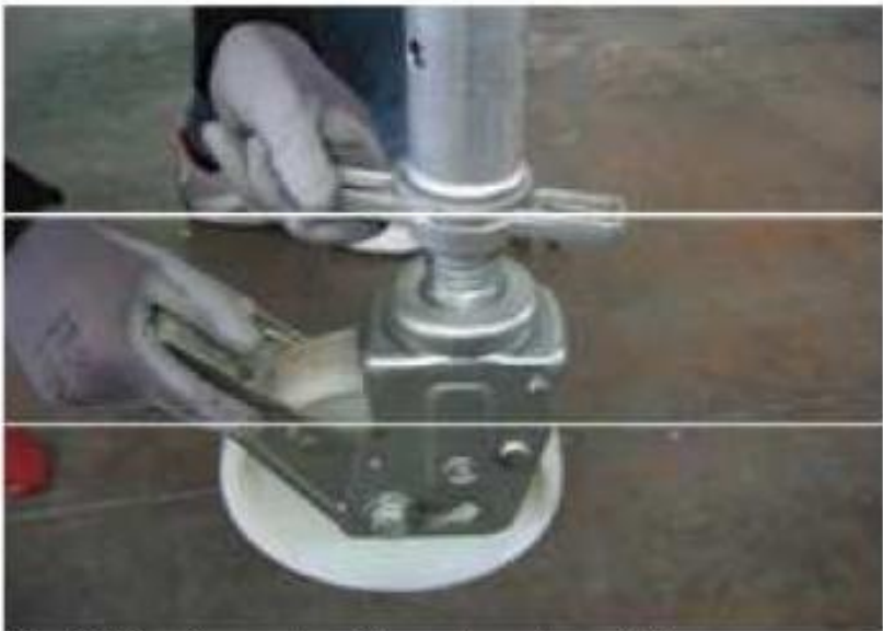
Fig.7: Livellamento del ponteggio mobile
