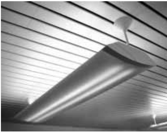
Figura 112 Lampada idonea per una postazione con VDT: lampada da soffitto a luce diretta/indiretta
