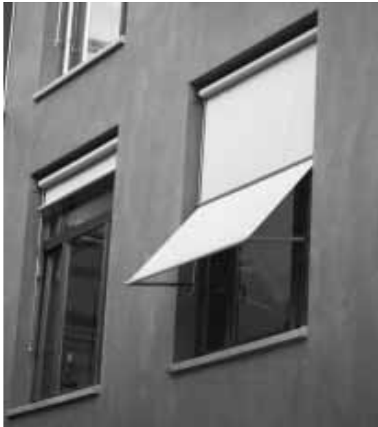
Figura 105 Tende in tessuto inadatte per una postazione al VDT (una stoffa troppo fine non ha alcun effetto oscurante, la luce penetra attraverso le fessure laterali)
