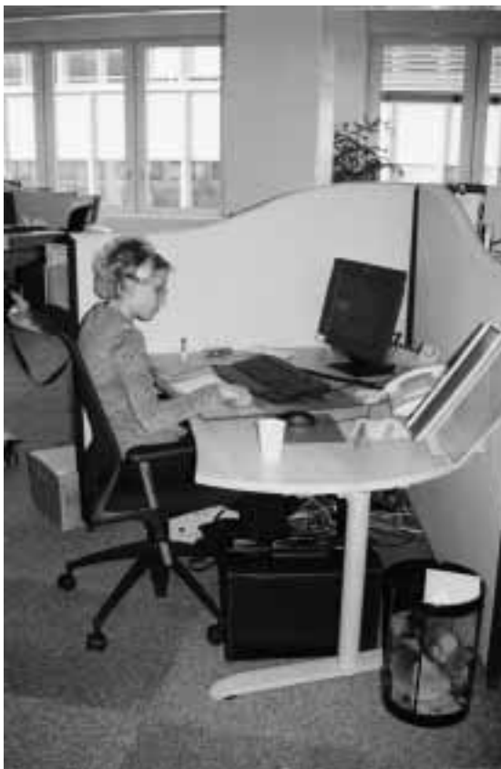
Figura 123 Pannelli fonoassorbenti che separano le singole postazioni di un call center
