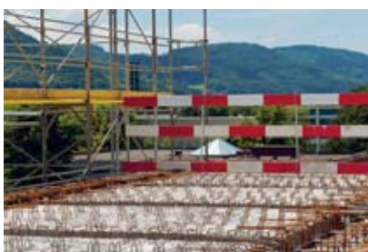
2 Preassemblare la protezione laterale.
