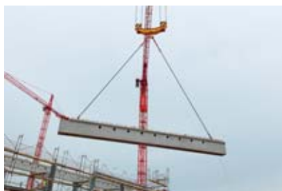
2 Imbracare correttamente i carichi asimmetrici.
