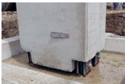
1 Piastra di base correttamente messa in sicurezza mediante 4 ancoraggi.
