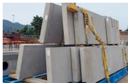
3 Mettere in sicurezza i componenti per evitare la caduta o lo scivolamento.
