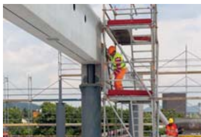
2 Lavoro di montaggio con vano scala: efficiente, sicuro ed ergonomico.
