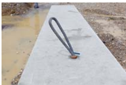
1 Montare i punti di ancoraggio nelle posizioni predefinite.
