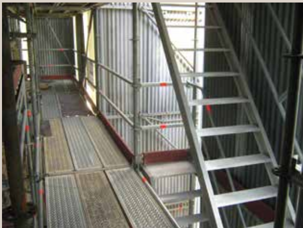
Fig. 7 Escalier d'accès extérieur et plancher de travail d'une largeur de 1 mètre
