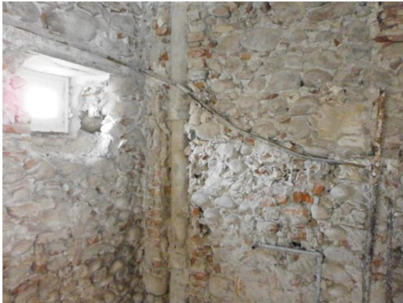
RINVENIMENTO DURANTE UNA RISTRUTTURAZIONE EDILIZIA
