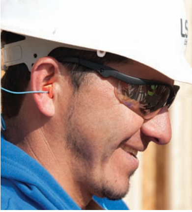
Trabajador que usa el EPI recomendado cuando trabaja con pistolas de clavo: casco, gafas de seguridad y protección auditiva
