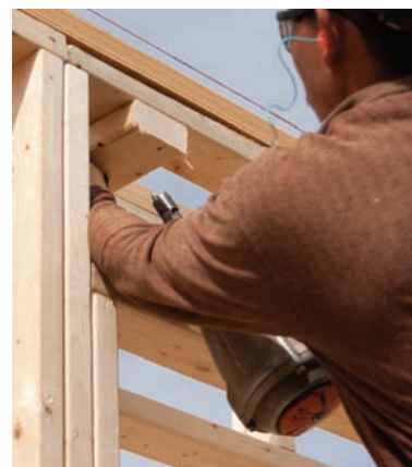
La penetración del clavo a través de la madera es una preocupación especial cuando la pieza se posiciona con la mano
